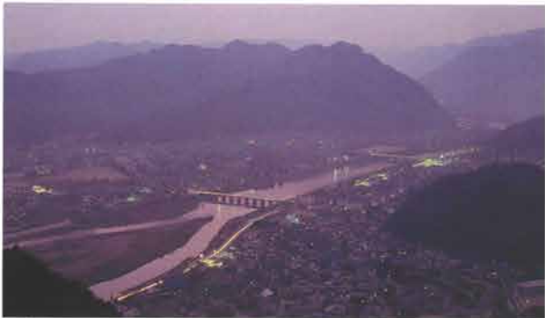
下水処理＝兵庫県上郡町
