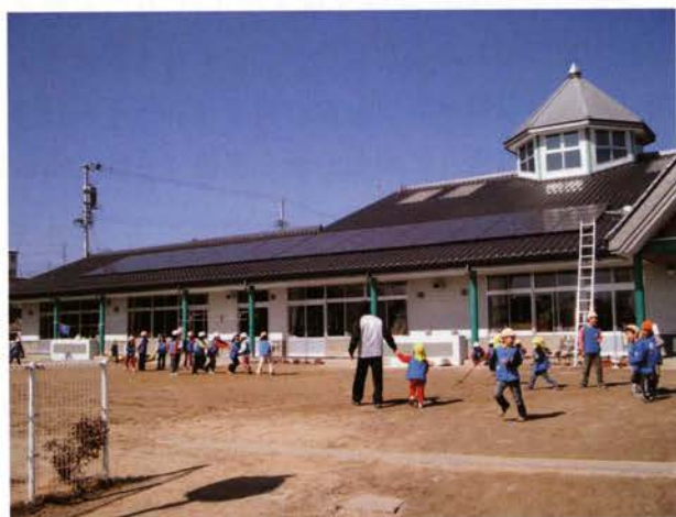
太陽光パネルを設置しているみつば保育園
