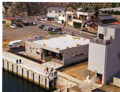
共同集出荷場 （左：荷さばき施設、右：製氷施設）
