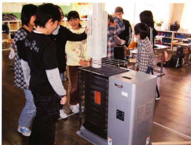
小学校のバイオマスボイラー
