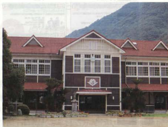
翠小学校の校舎
