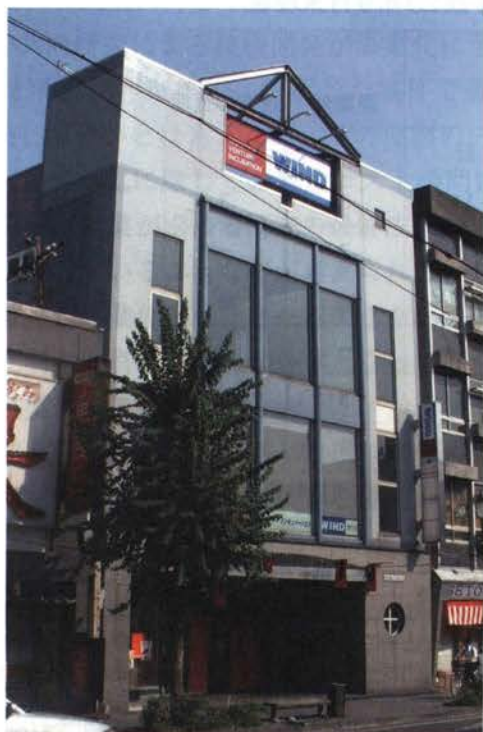
インキュベーション・オフィスWIND外観
