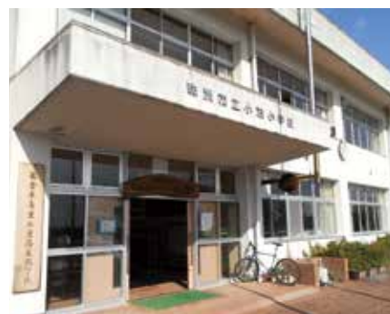
金沢大学能登学舎として活用されている旧珠洲市立小泊小学校。校舎3階の窓から美しい能登の里海が見渡せる
