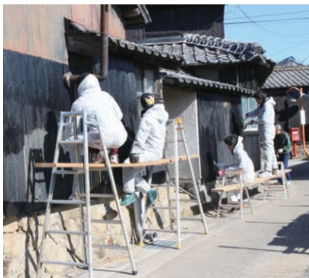
黒壁の修繕作業
