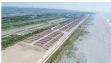
防潮堤整備状況（平成30年6月時点）
