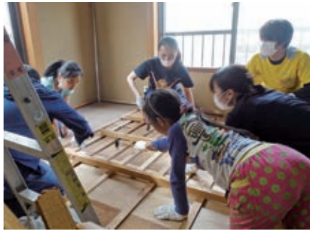
空き家リノベーション解体工事
