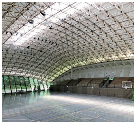
小国ドーム内部
