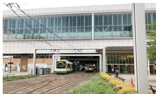
富山駅高架下LRT空間
