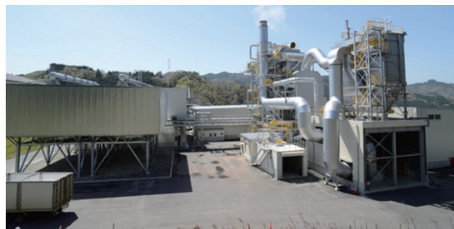
真庭バイオマス発電所
