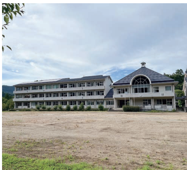
太陽光発電設備の設置：村立生坂中学校
