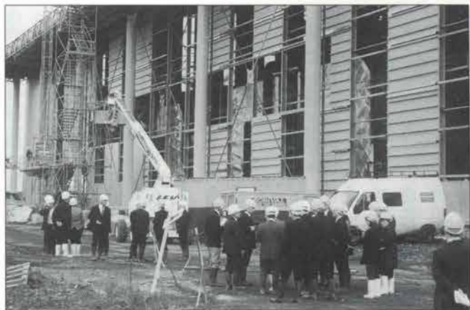
リール市の焼却炉工場建設現場
