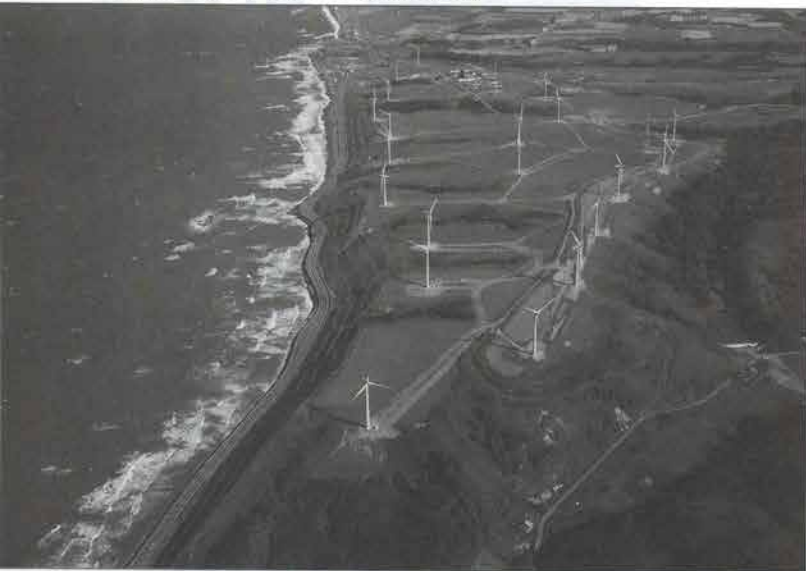
苫前グリーンヒルウインドパーク（1000kW×20基）
