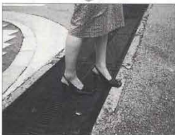
道路側溝のグレーチングの変更
