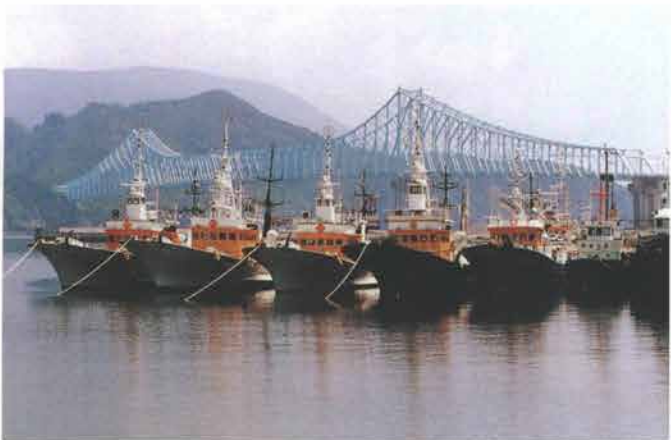
生月大橋 ＝長崎県生月町 大橋の完成で本土と直結。観光客が大幅増
