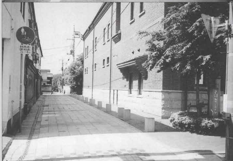
古河市鷹匠通の街路整備、施工前(上)施工後
