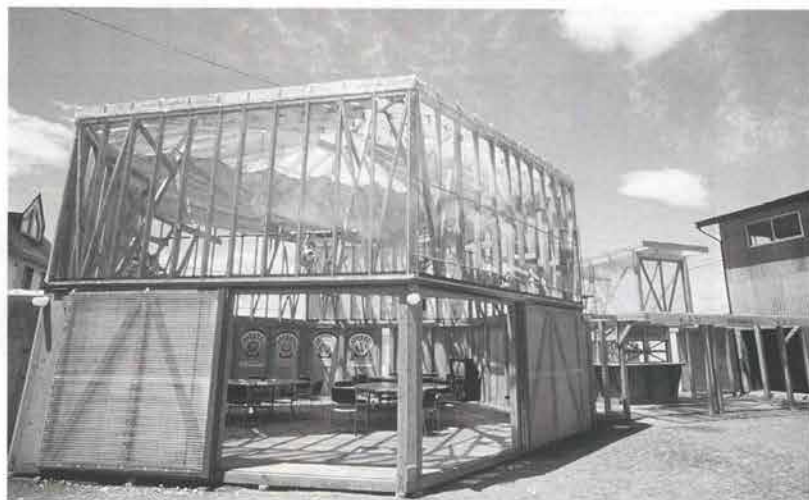
建設中の「インターゾーン」。ここでさまざまな催しが行われた (撮影：萩原美寛)
