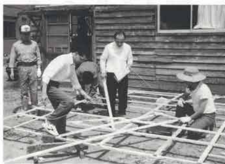
文字の型枠を作成中
