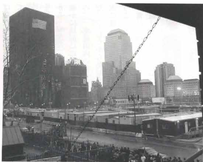
米国同時多発テロ——倒壊した２棟のワールドトレードセンタービル跡
