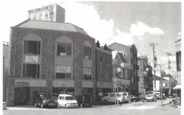
「レンガ通り」をテーマにした街並み整備（都市計画道路小松駅前線 小松市）
