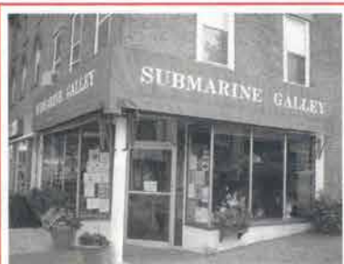
1階をギャラリー、2・3階をアートロフトに改装したビル
