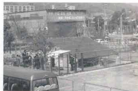
くるくる発電所の見学
