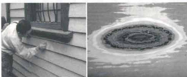
下見板ペンキ層のこすり出し(左) ペンキ層の時層色環(右)
