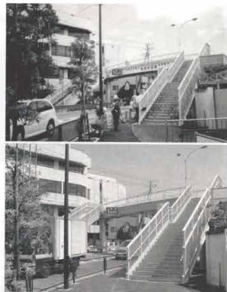
歩道橋塗り替え前（上） 塗り替え後（下）
