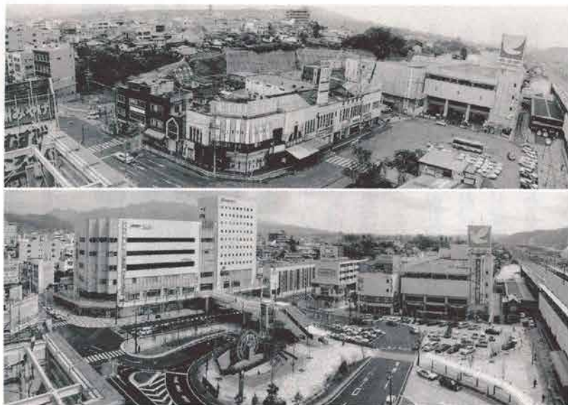
着工前のお城口の状況(上) 竣工後(下)
