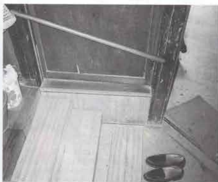
住宅改善の一例。勝手口の段差解消のため、階段手すりを取り付ける
