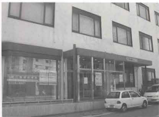
洲本第1ITベンチャーセンター
