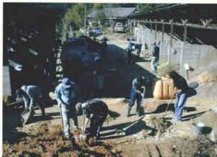
1次処理した生ごみに、もみがら、米ぬかなどを混和する第2次処理作業実地研修
