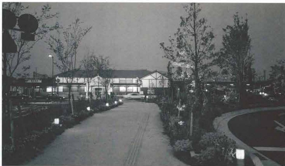
JR普通寺駅前夜間景観照明 (写真提供/株) 石井幹子デザイン事務所)
