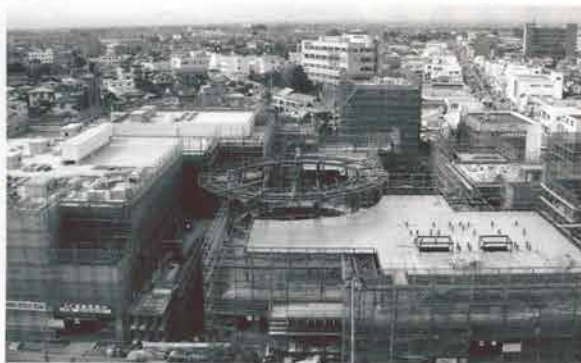
建設中の「リオーネふるかわ」
