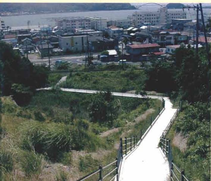
津波避難路を建設 ● 和歌山県串本町 (p30) 大水崎地区津波災害避難路
