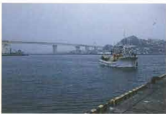
八戸港に架かる八戸大橋
