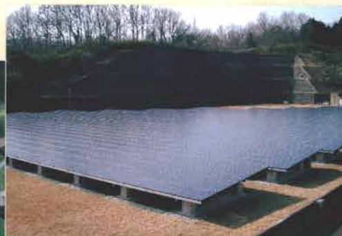
浄水池上部に設置された太陽電池パネル
