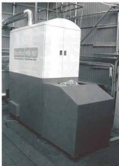
いわて型チップボイラー
