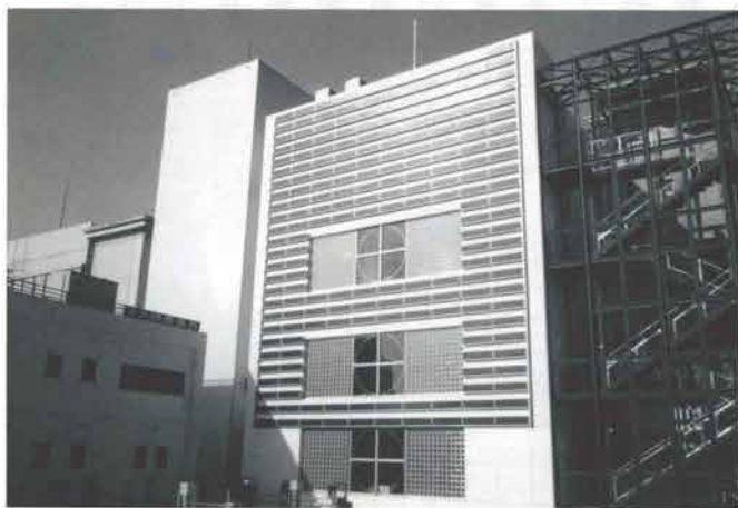
壁面にも太陽電池パネルを設置（川越市東口図書館）
