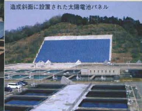
浄水池上部に設置された太陽電池パネル
