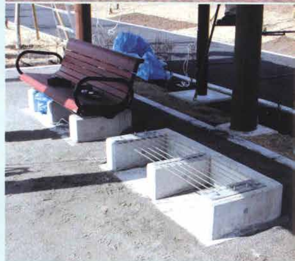
災害に備えた大洲防災公園 ● 千葉県市川市 (p14)
