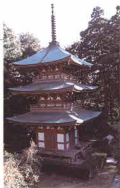
遠州3山の一つ油山寺の三重塔。高さ約23メートル、建久元年(1190年)に源頼朝公が眼病全快のお礼に建立したといわれる
