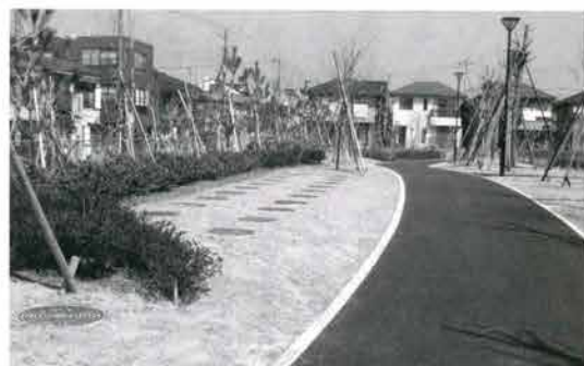
道路脇の芝生に点々とあるのは非常用の便槽。ブースを組み立てて利用する
