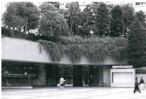
屋上壁面緑化の例
