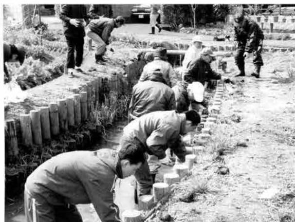
水辺づくり土木作業
