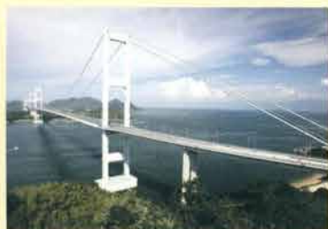
来島海峡大橋
