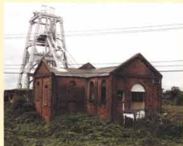
炭鉱盛時の面影を残す宮原坑跡 (国の重要文化財・史跡)。鉄骨の建造物は人や資材を降ろしたりする第2立坑、レンガ造りの建物は巻き上げ機室
