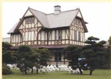
三井港倶楽部。三池港開港と同時に外国高級船員のクラブとしてオープンしたが、今はレストランなどとして市民に開放されている
