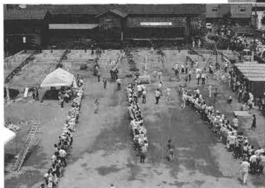
3本の綱で建物を引いた。滑車がついているのは一番右端のロープで16倍の力を発揮する
