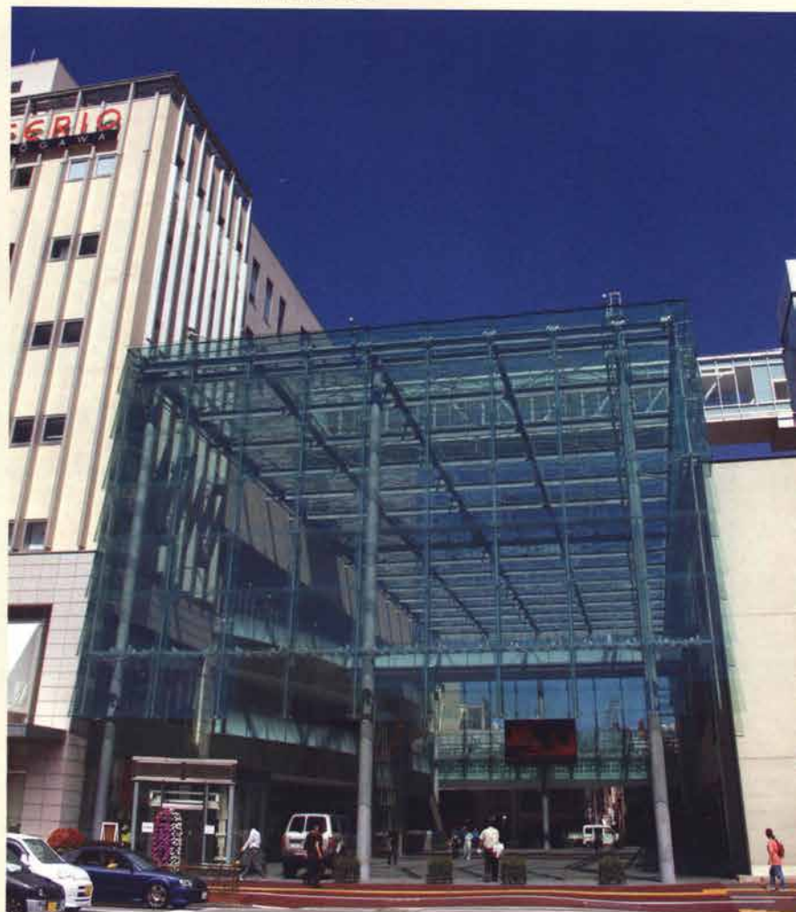
富山市グランドプラザ（全天候型広場）外観
