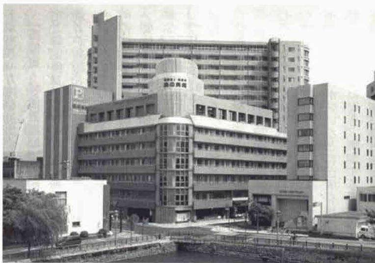
商業、福祉施設とマンションが一体になった「三の丸ビル」。これが都心への流れの拠点になった
