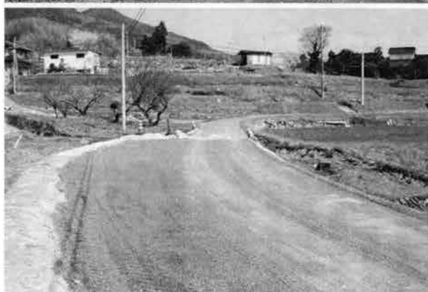
（上）施工前 （下）施工後
