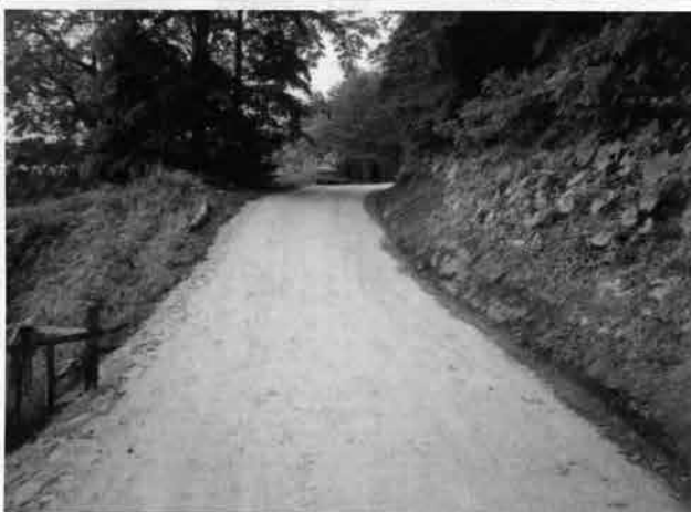
(上・中) ユイコのケアドー事業(町道横羽2号線作業風景) (下) 作業完了
