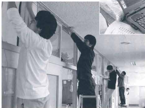
LAN配線工事の様子とパソコンの設定作業（右上）
