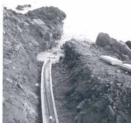
平成17年度に離島「大津島」へ敷設した海底ケーブル
