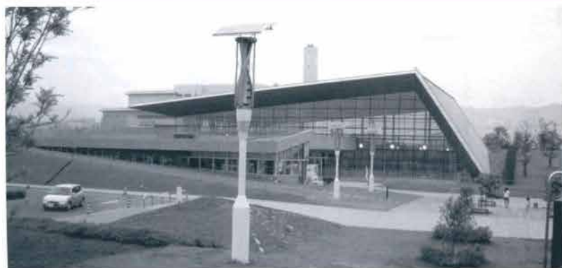
ごみ焼却場（後ろに煙突が見える）の余熱を利用している佐賀市健康運動センター。その前には風力、太陽熱を利用した外灯が立つ
