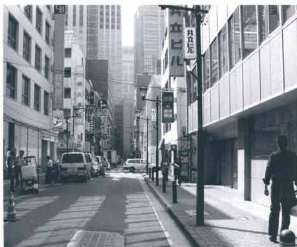
街路樹はおろか、プランターも植木鉢も見えない通り（東京・日本橋）
