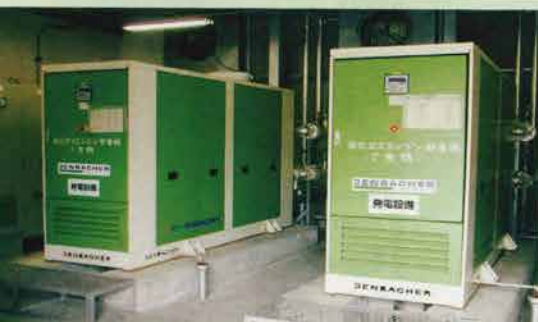
消化槽で発生したガス 燃料発電システム (上) ガス発電機 (下) ●京都府南丹市 (p18-19)
