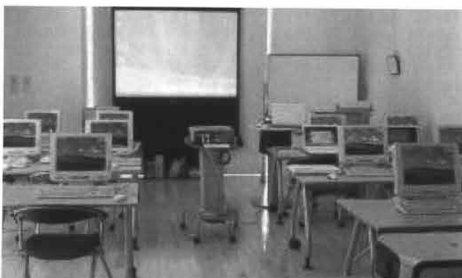
新しく完成したITルーム
