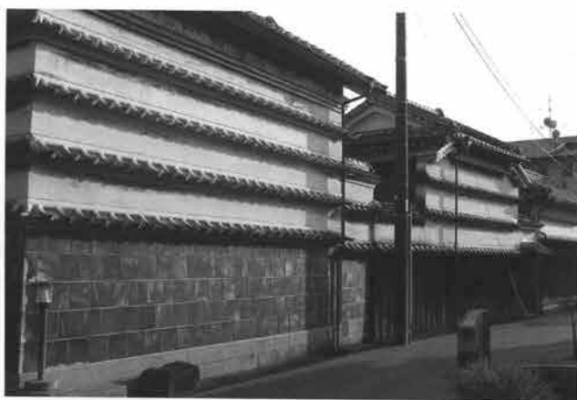
水きり瓦の見える通り
