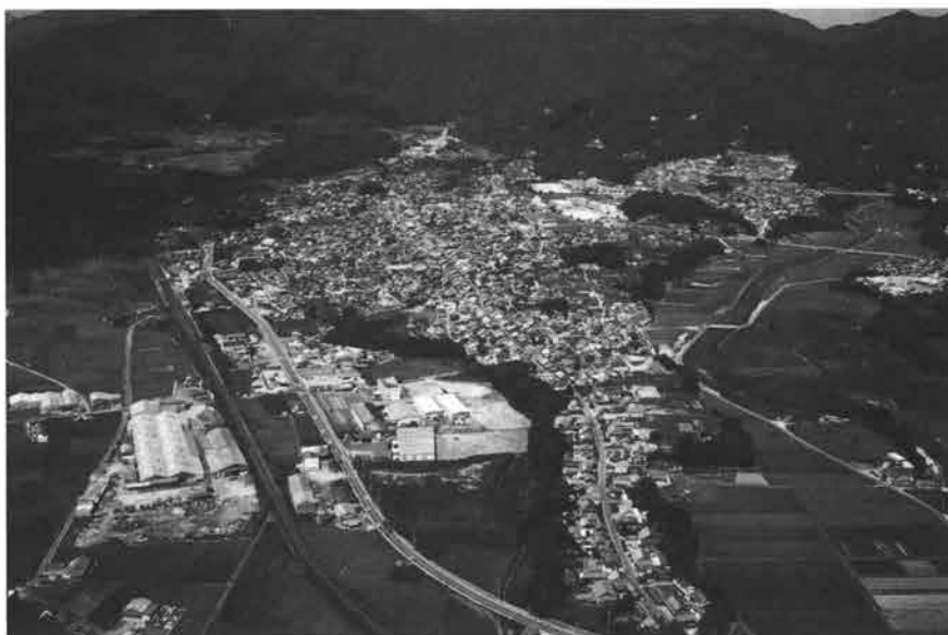
関宿全景、町並み中央を東海道が通る
