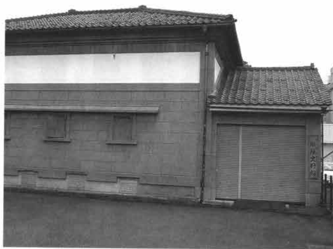
羽二重の倉庫であったケイター資料館
