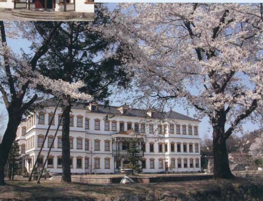
明治百年通りに移築、復原された鉾山事務所
