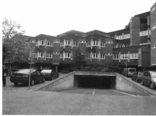
アムステルダムフェーン市役所
