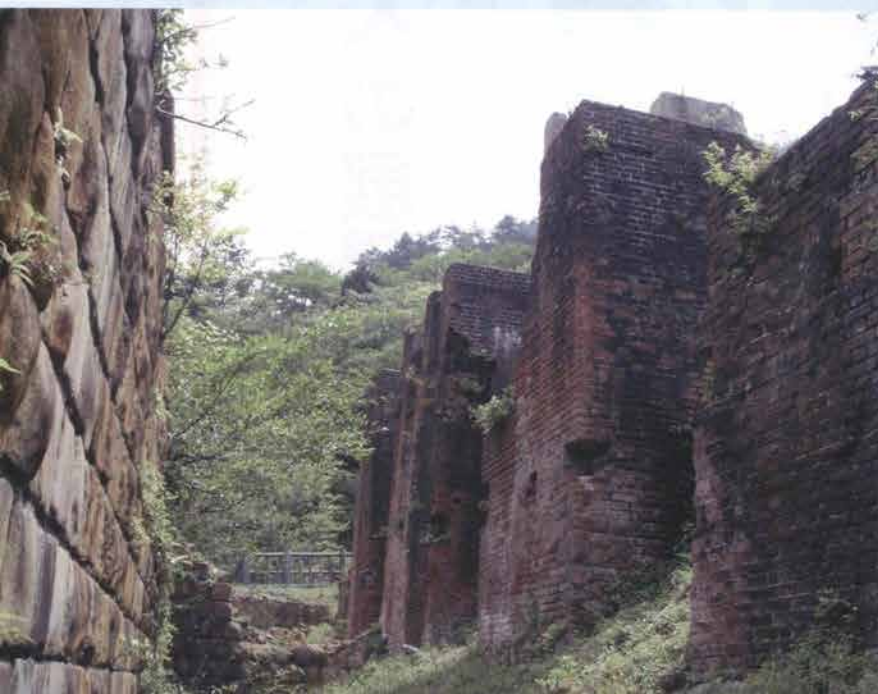
別子銅山の銅鉱石を貯蔵した東平貯鉱庫 ●新居浜市 (p20)
