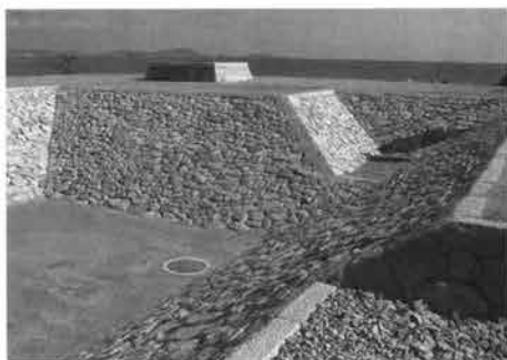
今春公開予定の犬島アートプロジェクト「精錬所」屋上
