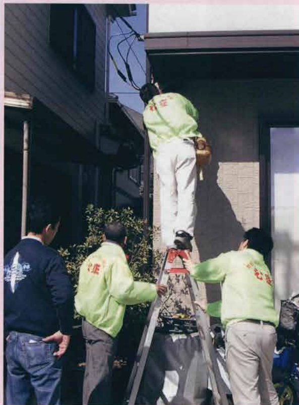
センサーライトの取り付け作業
