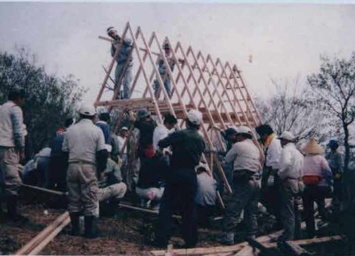
●北条地区コミュニティ振興協議会（新潟県柏崎市）（p15） 八石山の山頂に避難小屋を設置
