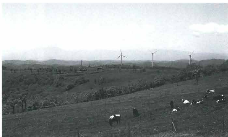
エコ・ワールドくずまき風力発電所
