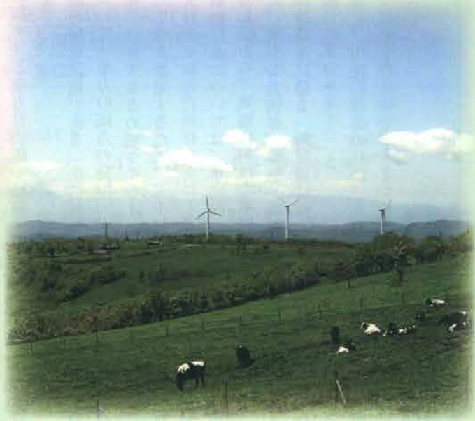
エコ・ワールドくずまき風力発電所 ●岩手県葛巻町 (p12-13)
