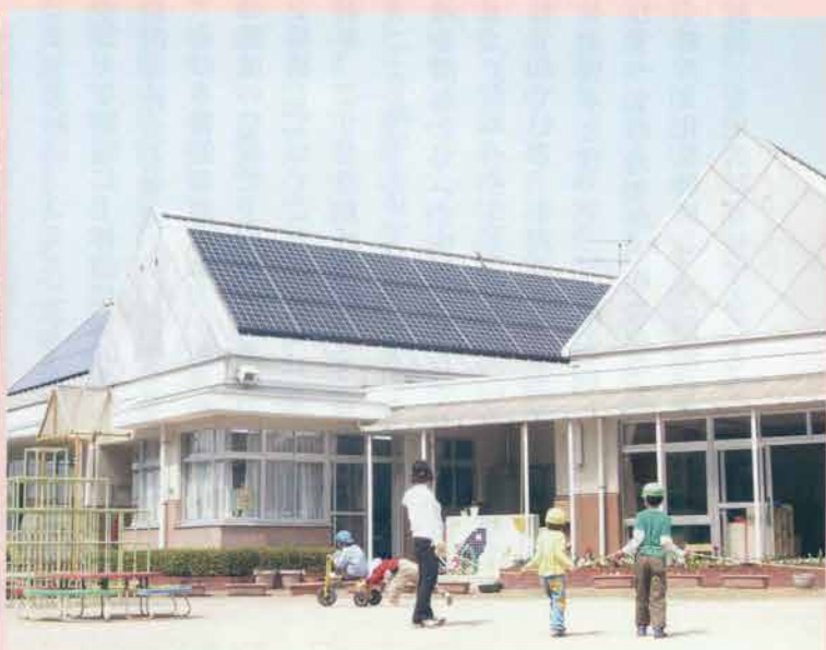
西鶴山保育園の太陽光設備 ●備前みどりのまほろば協議会(岡山県備前市) (p26-27)
