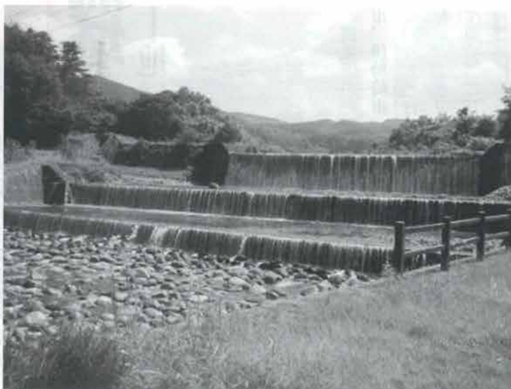
砂防堰堤群のシンボル地蔵原堰堤
