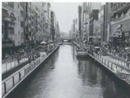
整備後の道頓堀川遊歩道（戎橋～太左衛門橋間）
