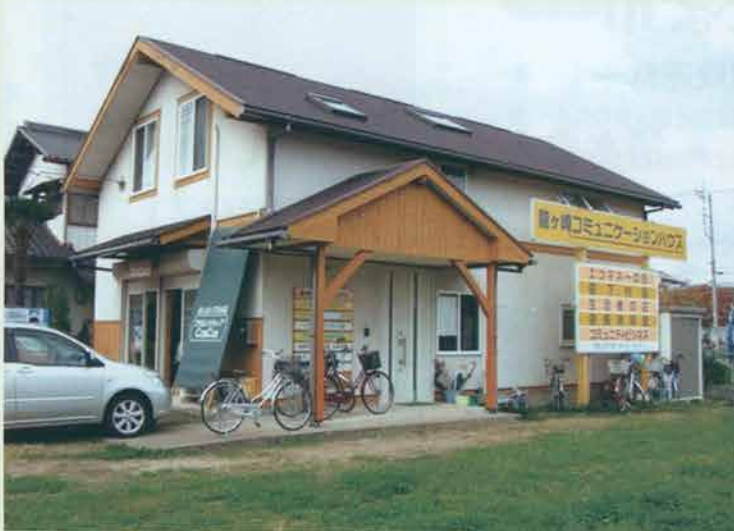
龍ヶ崎コミュニケーションハウスの外観
