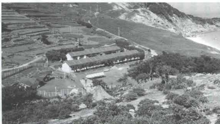
旧小値賀小・中学校分校校舎を転用した「野崎島自然学塾村」
