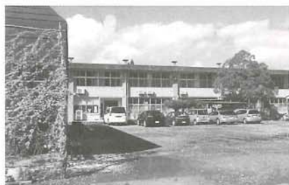
綾部市里山交流研修センター
