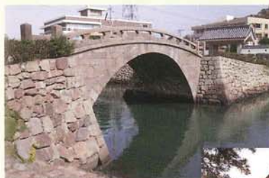
幸橋 (オランダ橋)
