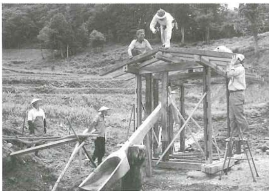
突き屋棟上げ
