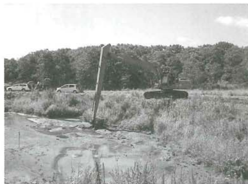
沈砂地の土砂上げの様子
