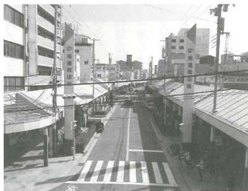
太陽光発電パネル、ドライ型ミストが設置される旭通商店街
