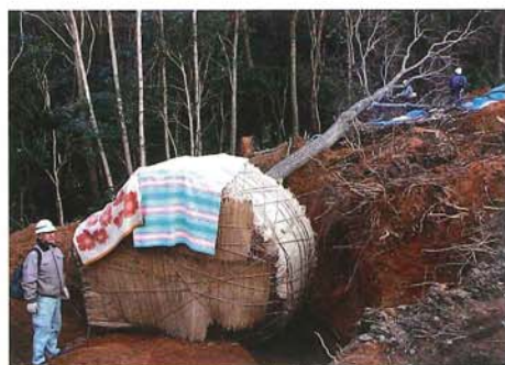
念願がかない伐採予定だったコナラの木の移植作業が始まった。
